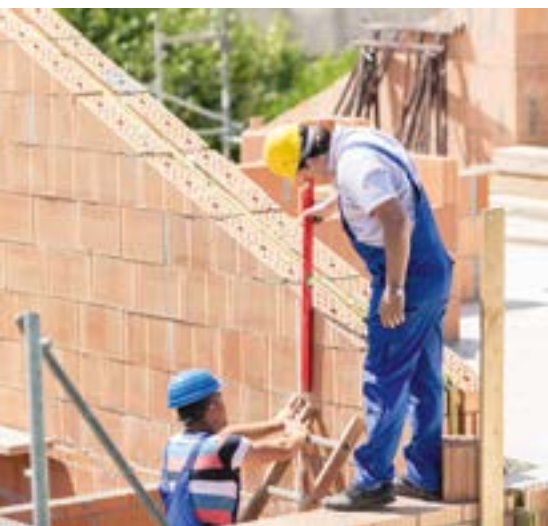
Im Bauhauptgewerbe haben sich die Auftragspolster vielerorts verkleinert
