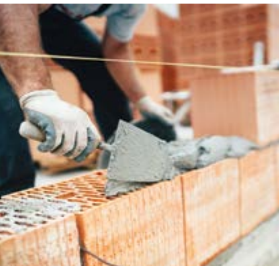
Noch läuft es im Bau rund. Die Nachfrage dürfte aber nachlassen.
